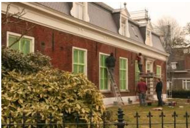
De restauratie van Schoorstraat 2 aan de buitenzijde
