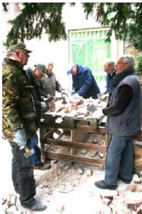
De vrijwilligers van 't Schoor bezig met het afbikken van de stenen voor de restauratie van de tuinmuur
