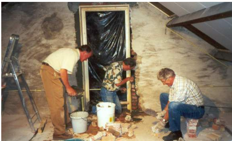
Gerard van Alem, Kees van de Wouw en Bert van Asten bezig met het maken van de branddeur
